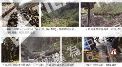
▲溪床下切點(L=200M、S=21%、H=50M)，持續縱向冲刷，崩塌嚴重，用電氣網護坡 ▲軌道路基被崩落，設置防冲牆 ▲溪岸兩側崩塌持續擴大、林木傾倒 ▲逾百年檜木群立地環境 ▲月台不均勻沉陷、間隙擴大
