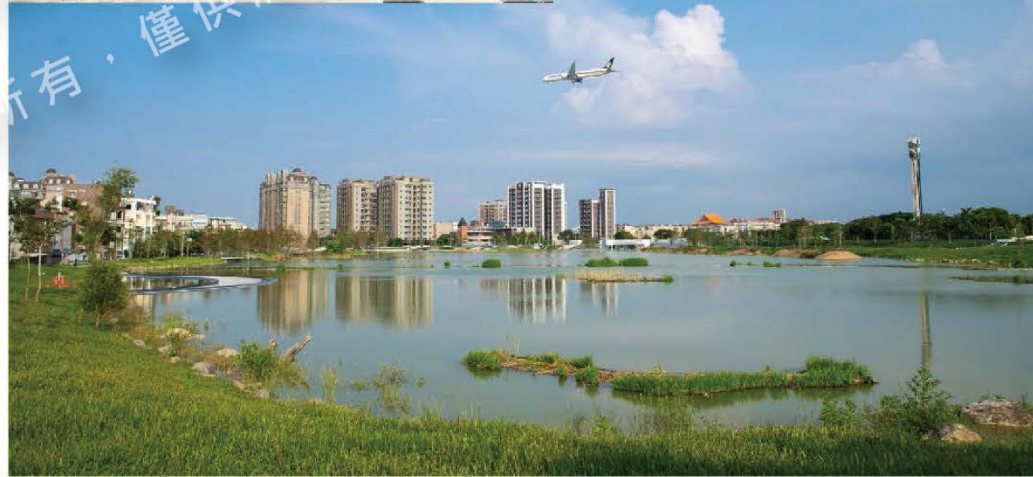
After 將埤塘底部挖深，土方回填至邊坡，創造廣大的緩坡綠色水岸，也創造人與生物的活動空間
