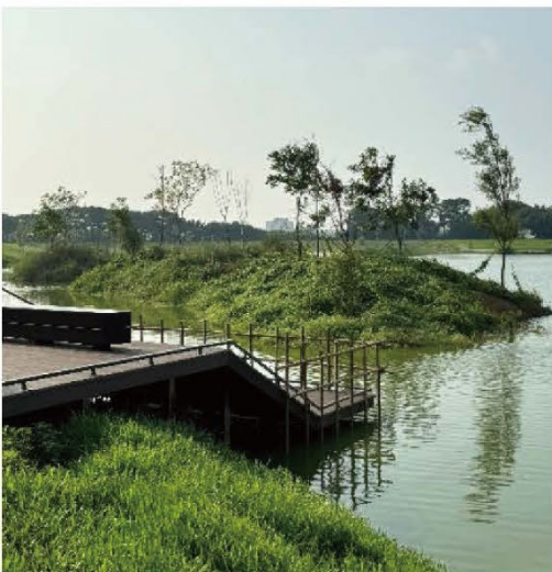
竹構欄杆：利用可逆式工法架設竹構欄杆，等民眾熟悉園區內水岸高差後可拆除增加親水性
