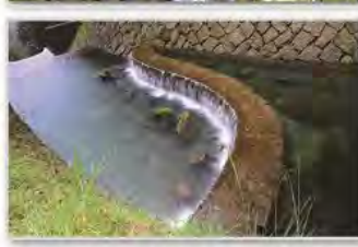
▲S型固床工營造跌水增加溶氧量，並形成水流流速不同的水域兼具景觀美感
