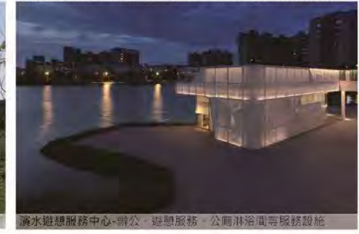
清水遊憩服務中心-辦公、遊憩服務、公園淋浴等服務設施
