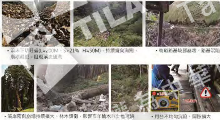
• 溪床下切壯盛(L=200M、S>21% H=50M)，持續縱向淘刷、崩塌嚴重，阻礙溪流通洪
